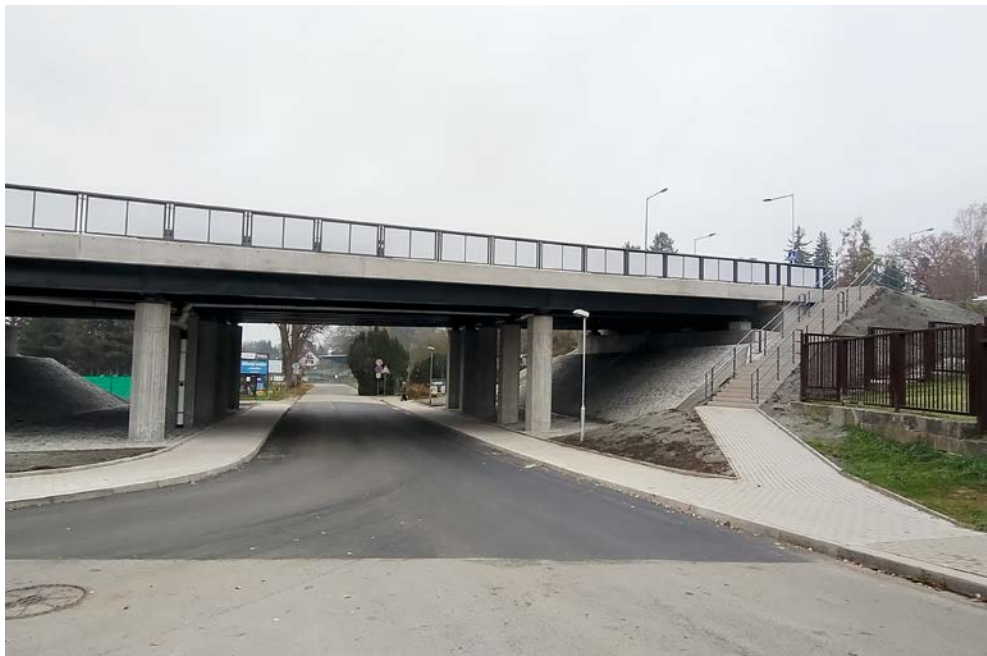
Silnice II/262 Dobranov-Česká Lípa, most ev.č. 262-004
